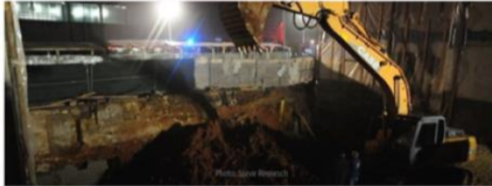
Vue de la profondeur de l'excavation côté chantier
